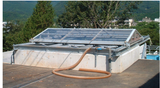
原尿濾過・貯留槽
